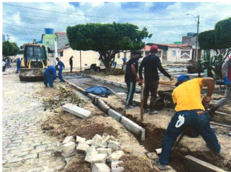
Foto 04 - ASSENTAMENTO DE GUIA (MEIO-FIO) EM TRECHO RETO, CONFECCIONADA EM CONCRETO PRÉ-FABRICADO, DIMENSÕES 100X15X13X20 CM (COMPRIMENTO X BASE INFERIOR X BASE SUPERIOR X ALTURA), PARA URBANIZAÇÃO INTERNA DE EMPREENDIMENTOS. AF_06/2016_P
